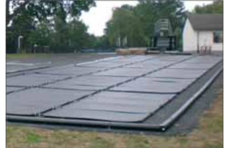
Montage auf ebener Freifläche
