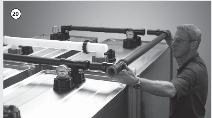
...in die freien Enden der Entlüftungsleitung der Tankreihen einstecken. ...insert into the free ends of the ventilation line of the tank rows. ...l'insérer dans l'extrémité libre de la conduite de purge des séries de réservoirs. ...in de vrije uiteinden van de ontluchtungsleiding van de tankrijen steken.
