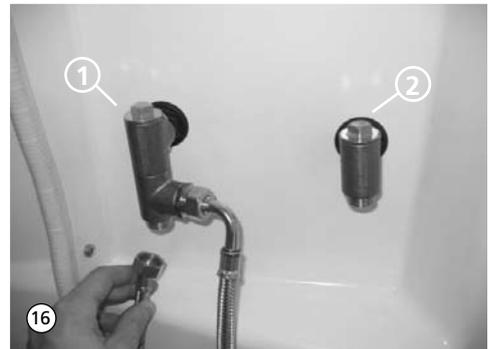
17. Verschraubungen fest anziehen. Verbindungen vor endgültiger Inbetriebnahme auf Dichtheit prüfen.
