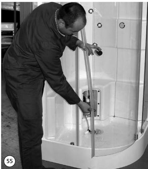
55. Magnetdichtung auf Türflügel aufstecken (Dichtung ist an den Enden auf Gehrung geschnitten).
