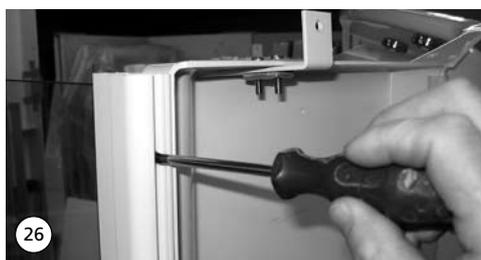
26. Seitenteile der Duschabtrennung verschrauben (6 Stück 4,2x13).
