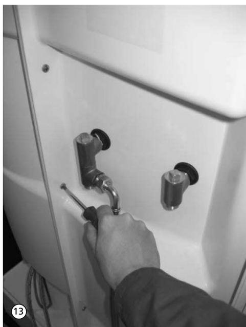
13. Zweite Paneelwand mit Duschwanne und Eckpaneel verschrauben (8 Stück M6x20), dabei Rückseite beider Paneelwände bündig ausrichten.
