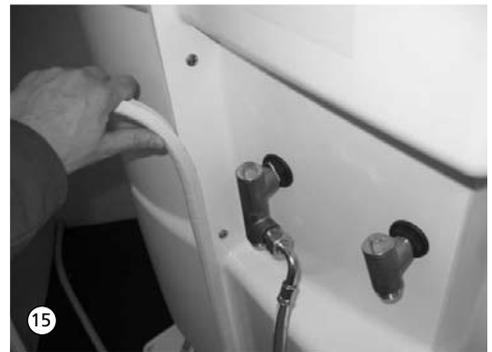
16. Flexible Anschlusschläuche des Durchlauferhitzers mit Armatur verbinden.
