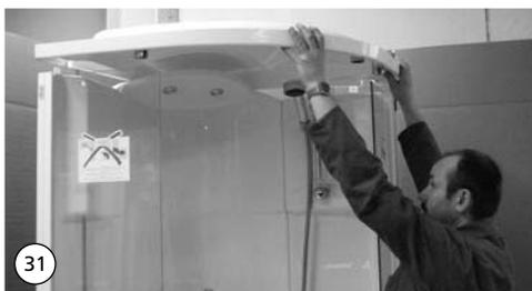
31. Dach vorsichtig auf Duschkabine auf-legen. Hierbei Glasscheiben in obere Lagerzapfen einfädeln. Glaskanten nicht beschädigen.
