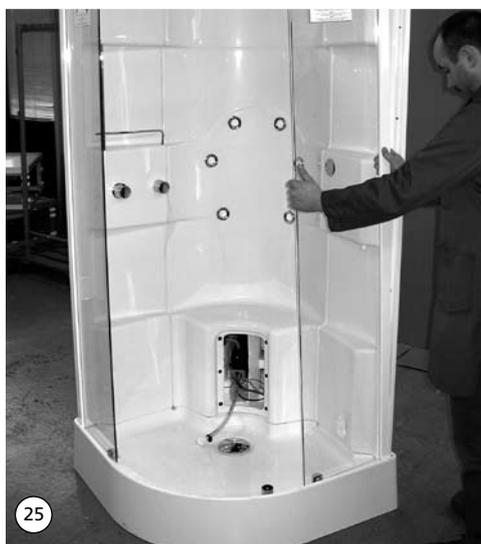
25. Seitenteile der Duschabtrennung in Kabine heben und in Aluminiumprofile einschieben. Gleichzeitig die Glasscheibe vorsichtig in den Lagerzapfen auf der Duschwanne einfädeln. Glaskanten nicht beschädigen. Beschriftung zur Lagekennzeichnung der Seitenteile auf dem Aufkleber beachten.
