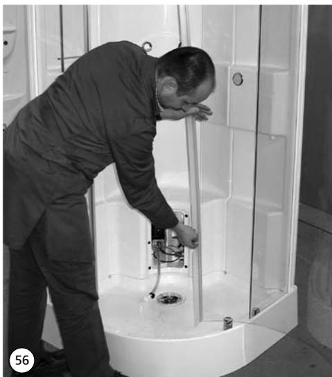
56. Senkrechte Spaltdichtung auf Türflügel aufstecken (Dichtung ist an den Enden auf Gehrung geschnitten).
