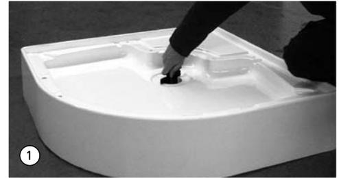
2. Wannenträger an vorgesehener Stelle ausschneiden. Bei Bedarf eigenen Durchbruch für Abwasserrohr herstellen.
