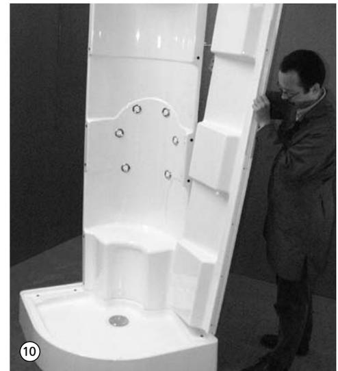
11. Erste Paneelwand mit Duschwanne und Eckpaneel verschrauben (8 Stück M6x20), dabei Rückseite beider Paneelwände bündig ausrichten.
