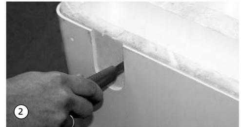
3. Abwasserrohre (nicht komplett im Lieferumfang enthalten) installieren. Bild zeigt Montage für Abwasserführung gemäß Planungsunterlage. Styroporabschnitt aus vorangegangendem Montageschritt zur Fixierung der Abwasserrohre verwenden.
