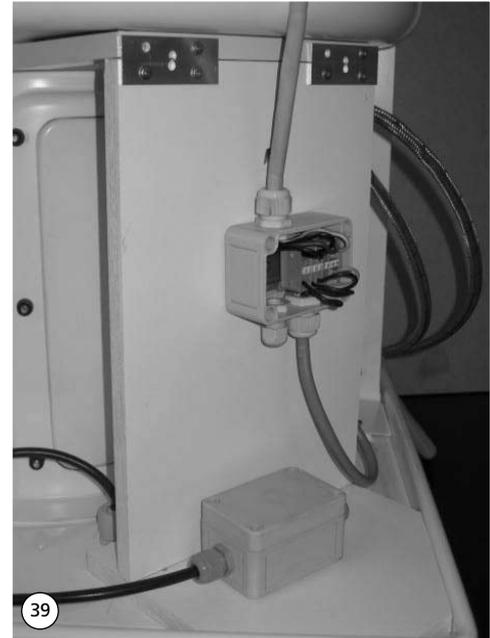
40. Bei Ausführung mit Pumpe bitte Anschlussdose am Pumpenkabel entfernen und Kabel in Anschlussdose des Durchlauferhitzers einführen. Leitungen entsprechend der beschrifteten Anschlussklemmen sorgfältig anschließen.
