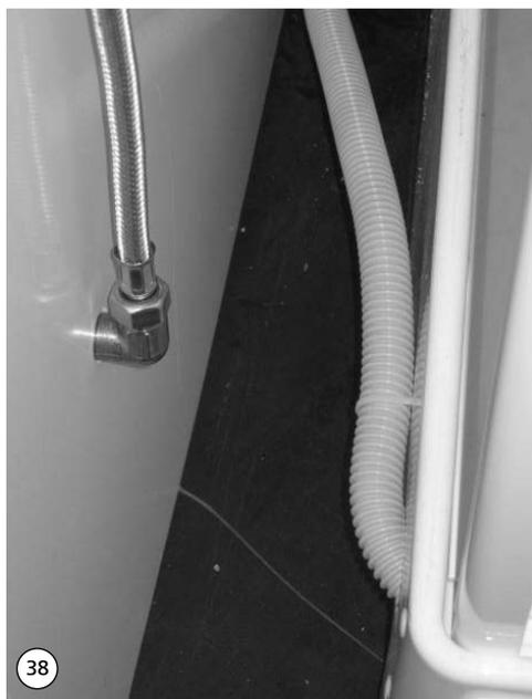
38. Wasserzuleitung gründlich spülen und für die Installation absperren. Duschkabine an Aufstellort schieben und Kaltwasseranschluss herstellen.
