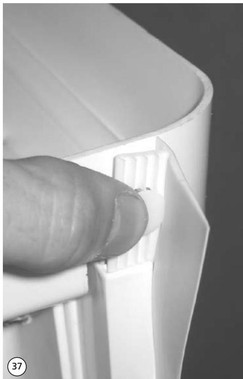
37. Bei Komplettduschen mit Dach Dichtlippe mit Kunststoffniet am Dach fixieren.
