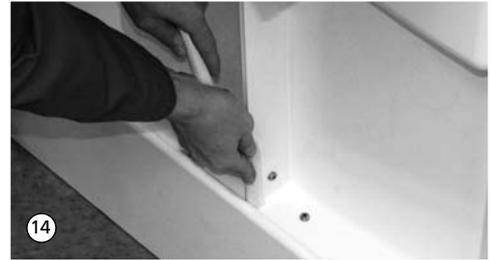
15. Dichtprofil auf kompletter Länge aufstecken (2 Stück).
