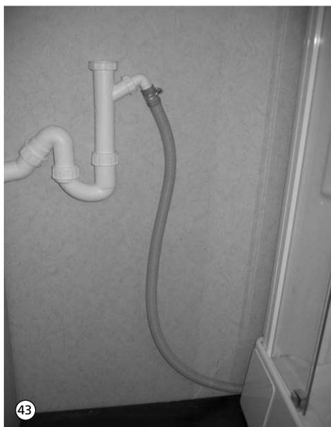
43. Bei Ausführung mit Pumpe den Entleerungsschlauch der Pumpe (Innendurchmesser 19 mm) an Entwässerungssystem anschließen.
