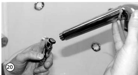
20. Handbrause mit Brauseschlauch verbinden. Beiliegende Dichtung benutzen.
