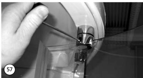
57. Türflügel bei Bedarf einjustieren. Hierzu Klemmschraube oben oder unten lösen und Glasscheibe justieren. Klemmschraube nach dem Ausrichten wieder fest anziehen. Keinesfalls beide Schrauben gleichzeitig lösen.
