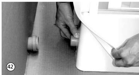
42. Duschkabine an Hauswand schieben. Hierbei Abwasseranschluß herstellen. Flexible Dichtlippe zur Seite schieben (entfällt bei Ausführung mit Pumpe).
