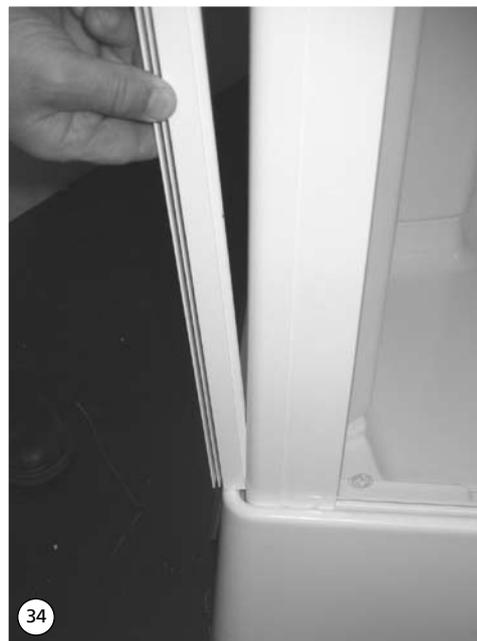
35. Flexible Dichtlippe in Aluminiumprofil eindrücken. Fallweise kann hierfür Nut 1 oder Nut 2 benutzt werden.
