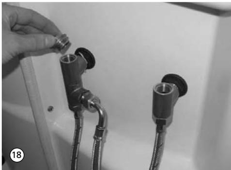
18. An den vorgesehenen Anschlüssen ist die Wasserversorgung einer zweiten Zapfstelle (z.B. Handwaschbecken) möglich. Hierzu Blindstopfen entfernen und Leitung anschließen.
