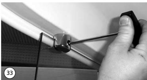
33. Dach nach unten ziehen und Seitenteile durch Anziehen der Klemmschraube am oberen Lagerzapfen fixieren.
