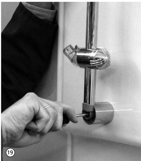
19. Gleitrohr an Paneelwand verschrauben.
