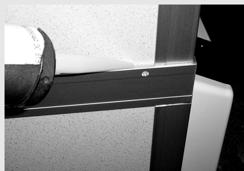
Nach abgeschlossener Kabinenmontage Oberteil und Unterteil umlaufend mit Silikon abdichten Après l'assemblage de la cabine, étanchéifier avec du silicone entre le haut et le socle. After installation of cubicle the upper and bottom part are sealed with silicone
