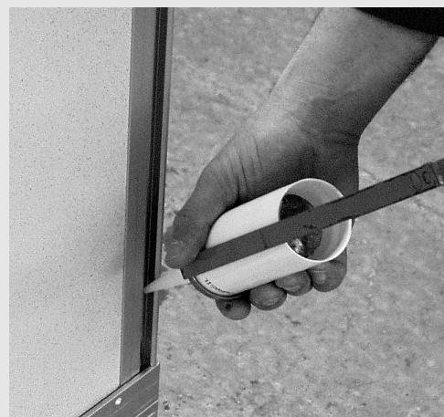
Silikon beim Aufklappen der Wandplatten in die Scharnierprofile einbringen Assurer l'étanchéité des profilés charnières. Filling silicone into the hinges while opening the wall tiles
