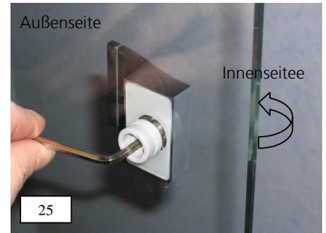
26. Zweite Griffhälfte zusammen mit der Griffunterlage von außen über die Befestigungshülse schieben und durch Eindrehen des Gewindestiftes M5 auf der Befestigungshülse fixieren. Gewindestift hierbei fest anziehen.
