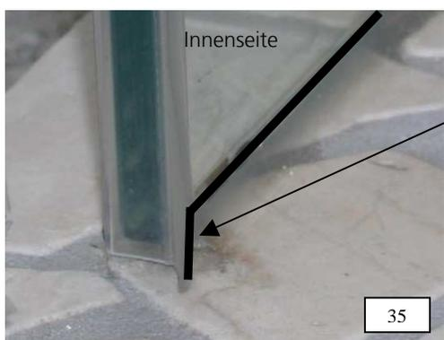
35. Zusätzlich wird die Spaltdichtung am anschlagseitigen Seitenteil im Bodenbereich nur auf der Innenseite mit Silikon versiegelt.
