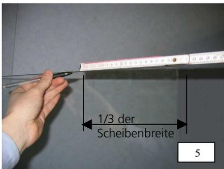
5. Montage Unifix Halterrohr an der Seitenwand. Gesamtbreite der Seitenwand, von der Wand bis Vorderkante Scheibe, messen. 1/3 der gemessenen Länge, ausgehend von der Vorderkante der Scheibe abmessen und Position auf der Scheibe markieren..
