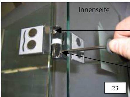
23. Nach korrekter Einstellung des Türflügels die beiden Sicherungsschrauben M3 fest anziehen. Die obere Schraube verhindert das ungewollte Aushängen des Türflügels. Sofern die Notwendigkeit besteht den Türflügel nochmals auszuhängen, ist diese Schraube vorher zu lösen. Die untere Schraube sichert zusätzlich die Fixierschraube des Hubrings gegen Lösen. Falls der Hubring neu justiert werden muss, ist diese Schraube vorher zu lösen.
