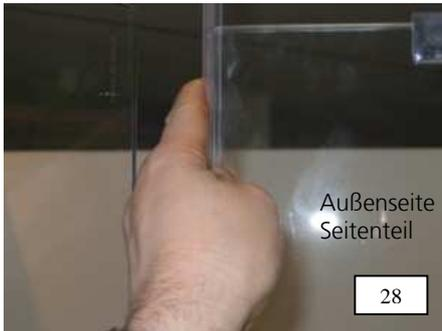
28. Spaltdichtung ebenfalls oben einige Zentimeter auf das Seitenteil aufstecken. Darauf achten, dass sich die Dichtlippe auf der Innenseite befindet. Unten wird sie auf die Duschlfläche aufgesetzt und anschließend mit der Scheibenoberkante bündig zugeschnitten.
