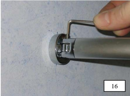
16. Das Halterohr wieder positionieren und Verbindung zur Gelenkplatte durch Eindrehen des Gewindestiftes M4 herstellen.
