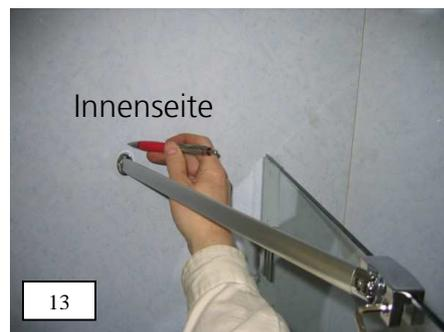
14. Gelenkkopf wieder von der Gelenkplatte lösen. Lochdurchmesser 8 mm an markierter Position bohren. Dübel setzen und Stockschraube M6 x 60 bis auf eine Restlänge von 6 – 8 mm eindrehen. Anschließend die Gelenkplatte aufschrauben und senkrecht ausrichten.
