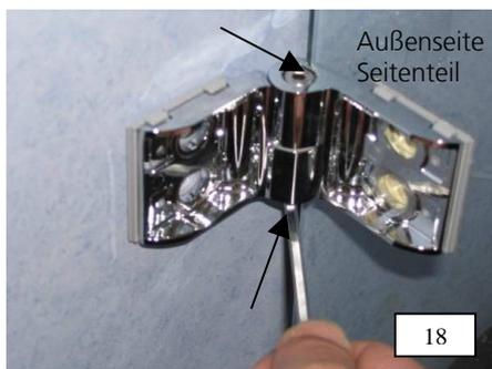
18. Seitenteil ebenfalls parallel zur Duschfläche ausrichten. Die beiden Schrauben an den Wandwinkeln der Seitenwand und vom Seitenteil können nun befestigt werden (siehe Pfeile).
