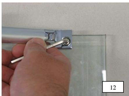
12. Unifix mit Scheibenhalter auf die Seitenwand aufstecken. Den Scheibenhalter mit der Vorderkante an die Markierung positionieren und mit dem vorderen Gewindestift M10 auf der Scheibe festklemmen.
