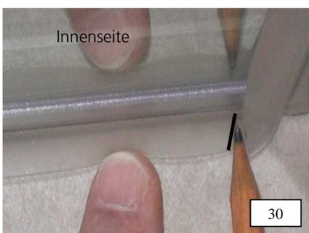
30. Damit die Dichtlippe durchgehend am Türflügel anliegt, muss wie dargestellt die Wannendichtung an der Vorderkante der Spaltdichtung angezeichnet werden.
