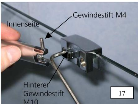
17. Parallele und lotrechte Ausrichtung der Seitenwand prüfen und eventuell korrigieren, danach Scheibenhalter mit dem vorderen Gewindestift M10 erneut an der Seitenwand fixieren. Bei korrekter Position das Halterohr vom Scheibenhalter mit Gewindestift M4 lösen (siehe Pfeil), und mit hinterem Gewindestift M10 ebenfalls fixieren. Anschließend das Halterohr wieder mit Scheibenhalter verbinden.
