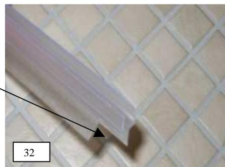
33. Die Verglasungsklotze unter den Seitenteilen müssen so abgeknickt werden, dass jeweils noch ein Stück davon unter den Scheiben verbleibt. Nun kann mit der Vorbereitung zur Versiegelung begonnen werden
