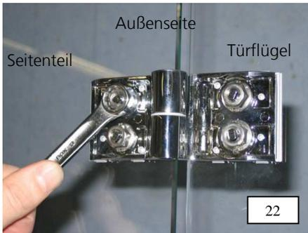
22. Falls erforderlich lässt sich der Türflügel zusätzlich noch über den Beschlag ausrichten. Hierzu mit geeignetem Montagewerkzeug SW 13 die Befestigungsmuttern M8 lösen und Einstellung vornehmen. Achtung vor dem Lösen der Befestigungsmuttern untere Scheibenkanten mit beiliegendem Kantenschutzprofil sichern. Die Befestigungsmuttern M8 sind anschließend mit einem Drehmoment von 15 Nm anzuziehen.
