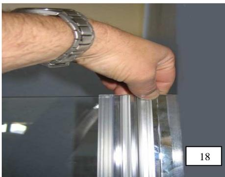
18. Die Türmagnetdichtungen am Türflügel oben ebenfalls einige Zentimeter aufstecken. Bündig mit Türscheibenunterkante montieren und an ihrer Oberkante abschneiden. Bitte beachten, die Dichtungen müssen sich gegenseitig anziehen (Polarität). Tür und schließseitige Profileinheit miteinander ausrichten. Hierzu muss das 6 mm U- Profil entsprechend zum Türflügel eingestellt werden.
