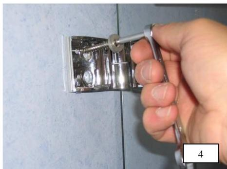
4. Seitenteile erneut ausrichten und jeweils beide Beschläge mit je 2x Schrauben 6 x 80 mm und 2x U- Scheibe 6,4 mm befestigen.
