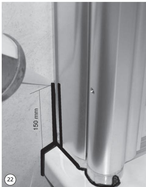
22. Versiegelung von außen circa 150 mm senkrecht in der Höhe und waagrecht an der Gelenkplatte bis zur vorderen Öffnung. Diese komplett versiegeln.
