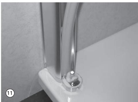
11. Die Gelenkdichtung ganz nach unten auf die Gelenkplatte drücken und anschließend auf der ganzen Länge vorsichtig in den Pfosten eindrücken.
