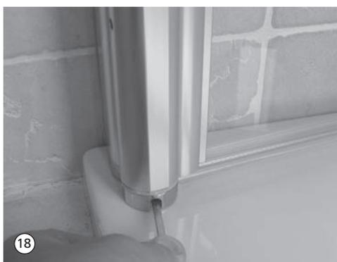
18. Bei Bedarf kann der Türflügel abgesenkt werden, Innensechskantschlüssel SW 3 verwenden. Auslieferungszustand ist oberste Stellung. Anheben ist nur möglich, wenn der Flügel demontiert ist.
