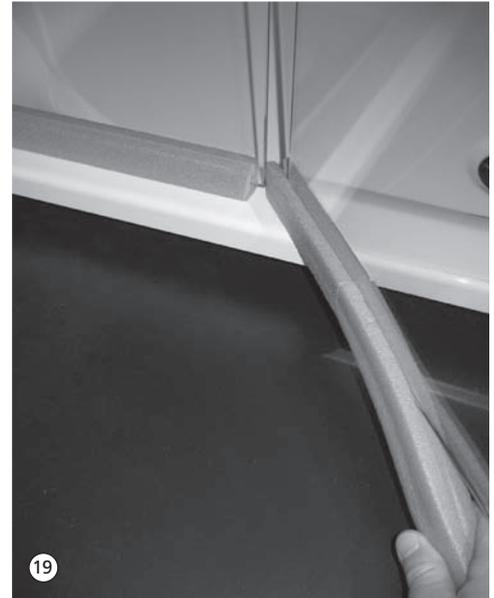
20. Beim Montieren der Wannendichtung darauf achten, dass der schräge Abweiser zur Innenseite zeigt. Beim Zuschneiden der Länge am Türflügel muss diese hinten an der Gelenkplatte anliegen.
