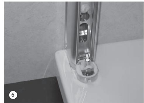
7. Lotrecht ausrichten und mit den Spaxschrauben 4,5 x 45 mm befestigen.
