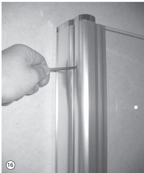
16. Türflügel lotrecht ausrichten. Hierzu wird der Flügel nach innen gefaltet, die Bohrungen der Justierschrauben am Drehprofil werden sichtbar. Mit Innensechskantschlüssel SW 4 Einstellung vornehmen.
