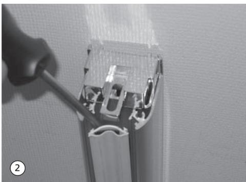
2. Obere Gelenkplatte und Gelenkdichtung lösen und demontieren.
