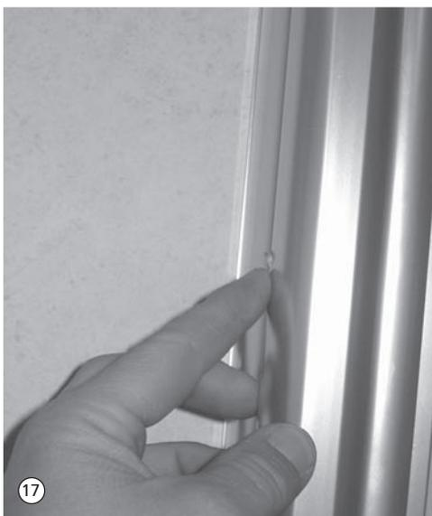
17. Die Bohrungen am Außenprofil mit den beiliegenden Justierschraubenabdeckungen verschließen.
