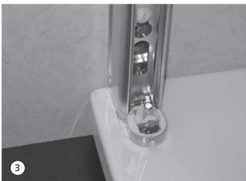
3. Gelenkeinheit an die Markierung setzen.
