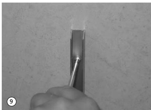
9. U-Profil wieder an die Markierung setzen, lotrecht ausrichten und mit Spaxschrauben 4,5 x 45 mm befestigen.
