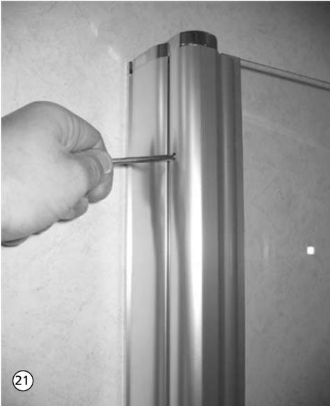
21. Flügel Anschlagseite lotrecht ausrichten. Hierzu wird der Flügel nach innen gefaltet, die Bohrungen der Justierschrauben am Drehprofil werden sichtbar. Mit Innensechskantschlüssel SW 4 Einstellung vornehmen.
