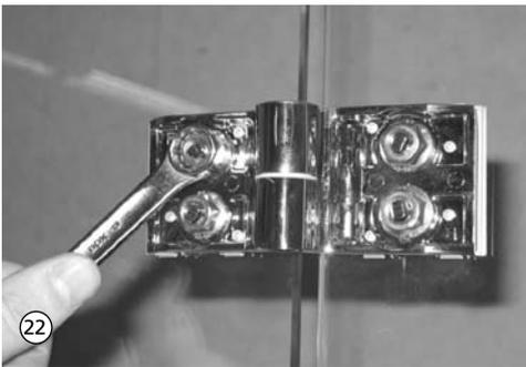
22. Falls erforderlich lässt sich der Flügel Schließseite ebenfalls ausrichten. Hierzu mit geeignetem Montagewerkzeug SW 13 die Befestigungsmuttern M8 lösen und Einstellung vornehmen. Achtung vor dem Lösen der Befestigungsmuttern untere Scheibenkanten mit Kantenschutzprofil sichern.
