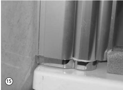
15. Das Außenprofil nach unten auf die Gelenkplatte schieben.
