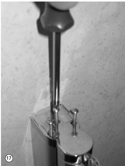
17. Mit 3 Linsenkopfschrauben 3,5 x 32 mm befestigen.
