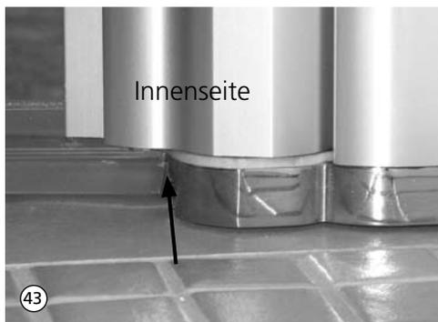
43. Pfeil zeigt die endgültige Position der Dichtung an der unteren Gelenkplatte.
