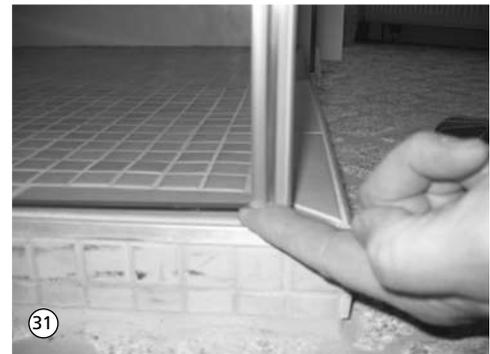
32. Tür und Seitenwand so zueinander ausrichten, dass sie parallel zur Wanne oder Fuge verlaufen. Eventuell Korrekturen an der Tür mit den Justierschrauben vornehmen wie unter Punkt 21 beschrieben. Die Seitenwand wird im U-Profil entsprechend korrigiert. Seitenwand nochmals lotrecht ausrichten. Anschließend U-Profil mit der Seitenwand verbohren. Bohrer Durchmesser 2,3 mm.
