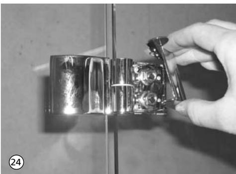
24. Beschlagabdeckungen montieren. Dabei Zuordnung Links „L“ und Rechts „R“ beachten. Vor Montage der Beschlagabdeckungen nochmals alle Befestigungsmuttern M8 mit einem Drehmoment von 15 Nm anziehen.
