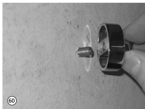
61. Alternativ Stockschraube M6 x 60 zunächst in die Gelenkplatte eindrehen. Danach vormontierte Gelenkplatte mit Stockschraube, wie dargestellt, mit Maulschlüssel SW 8 in Dübel eindrehen.
