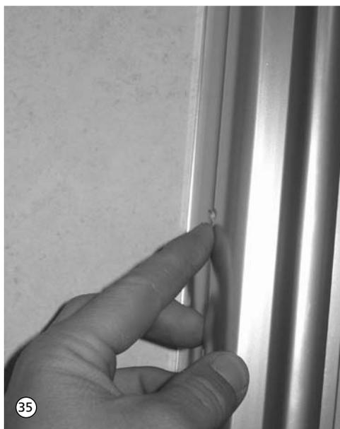
35. Die Bohrungen am Außenprofil mit den beiliegenden Justierschraubenabdeckungen verschließen
