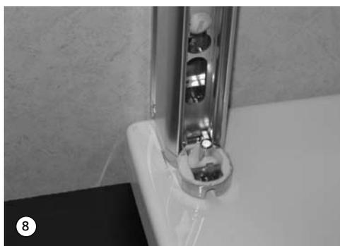
8. Gelenkeinheit wieder an die Markierung setzen, lotrecht ausrichten und mit Spaxschrauben 4,5 x 45 mm befestigen.
