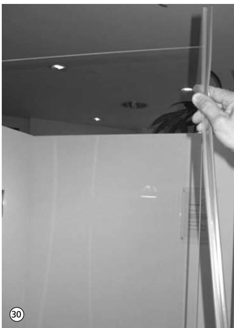
30. Türmagnetdichtung auf den schließseitigen Flügel oben einige Zentimeter auf die Scheibe aufstecken. Somit wird verhindert, dass die Dichtung abknickt und dadurch unbrauchbar wird.
