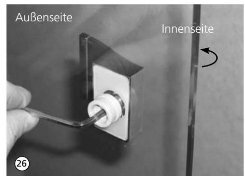
27. Zweite Griffhälfte gemeinsam mit Griffunterlage über Befestigungshülse schieben und durch Eindrehen des Gewindestiftes M5 auf Befestigungshülse fixieren. Gewindestift hierbei fest anziehen.
