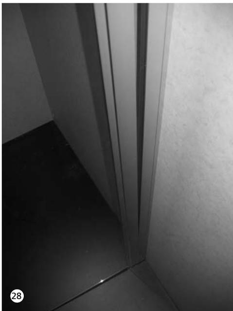
28. Seitenwand vorsichtig mit dem Aluprofil in das U-Profil einschieben und darauf achten, dass die Scheibenkanten beim Aufsetzen auf die Wanne oder den Boden nicht beschädigt werden.
