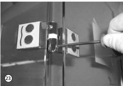
23. Nach korrekter Einstellung der Türflügel die beiden Sicherungsschrauben M3 fest anziehen. Die obere Schraube verhindert das ungewollte Aushängen der Türflügel. Falls die Türflügel nochmals ausgehängt werden müssen, ist diese Schraube vorher zu lösen. Die untere Schraube sichert zusätzlich die Fixierschraube des Hubrings gegen Lösen. Falls der Hubring neu justiert werden muss, ist diese Schraube vorher zu lösen.
