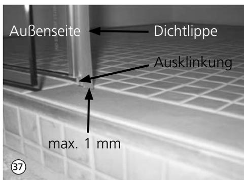
37. Die Spaltdichtung so auf den anschlagseitigen Flügel (erster Flügel an der Gelenkeinheit) montieren, dass sich die Ausklindung (siehe Pfeil Ausklindung) unten befindet und die Dichtlippe später innen am schließseitigen Flügel anliegen kann. Der Abstand zwischen Unterkante der Dichtung und der Duschfläche darf maximal 1 mm betragen.
