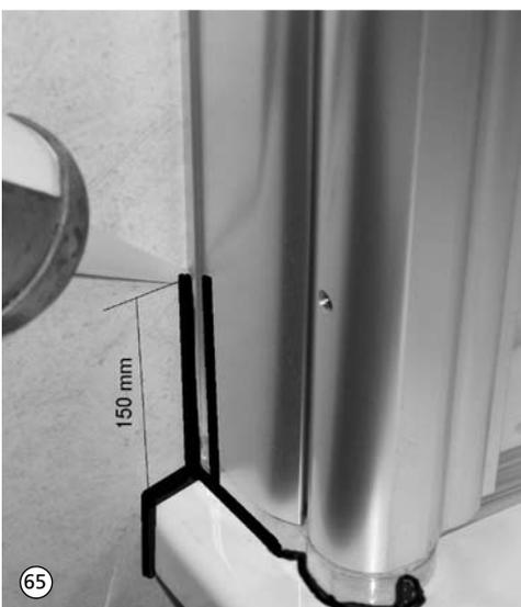
65. Versiegelung an der Gelenkeinheit von außen circa 150 mm senkrecht in der Höhe und waagrecht an der Gelenkplatte bis zur vorderen Öffnung. Die Öffnung komplett versiegeln.
